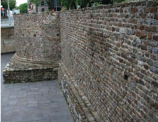
Rekonstruierter Teil der Mauer mit Turm
