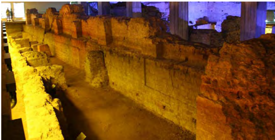
Fundamente der östlichen Außenfassade
