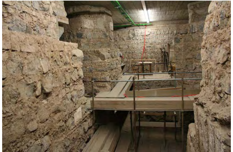
Pfeilerfundamente des gotischen Domes
