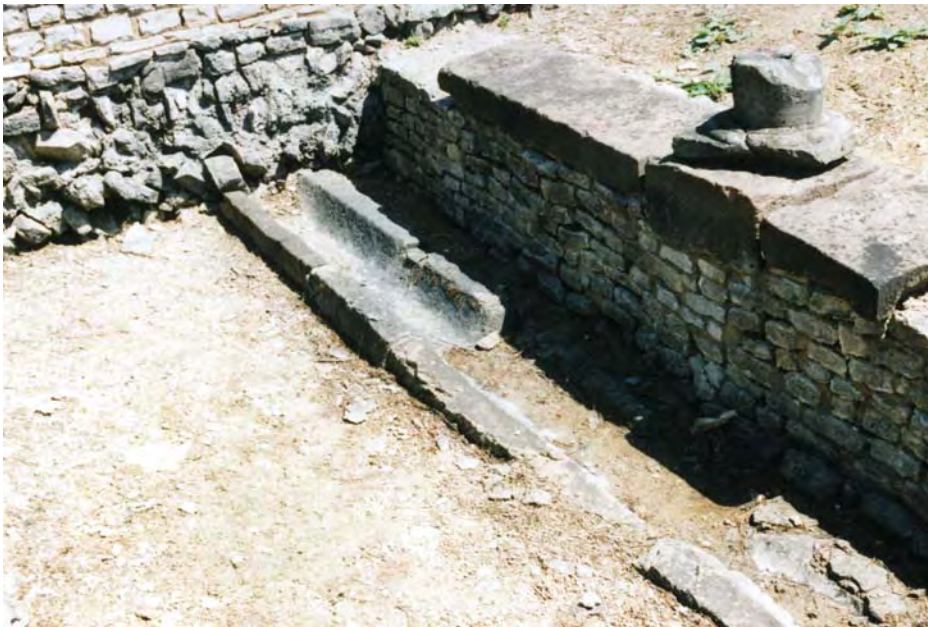
St. Ulrich, Abflusssrinne im Peristylbereich
